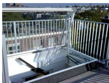
Dakbetreding, met elektrische bediening
